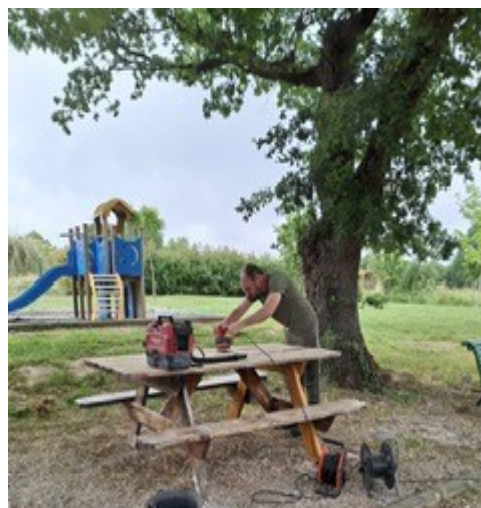
Rénovation table de pique-nique
